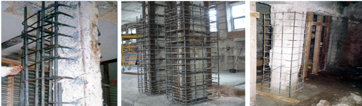
Hình 2. Gia cường bằng cách tăng kích thước tiết diện cột
