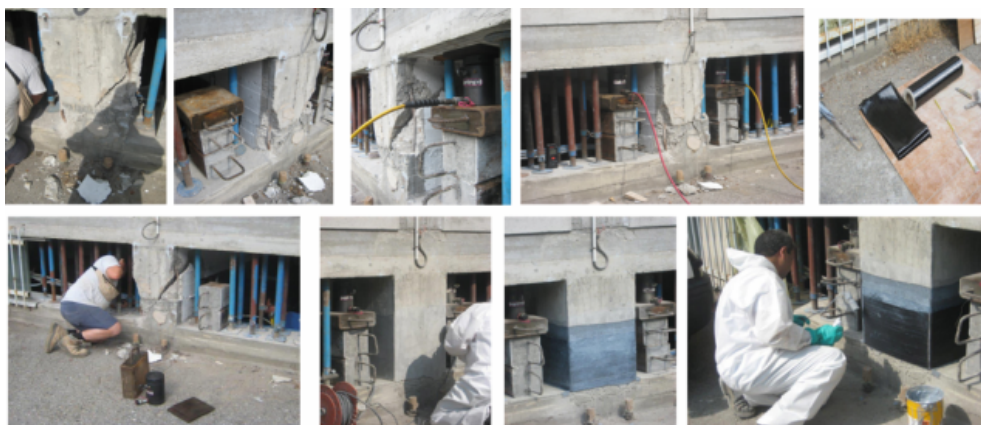
Hình 7. Gia cường cột BTCT bằng vật liệu cốt sợi tổng hợp
