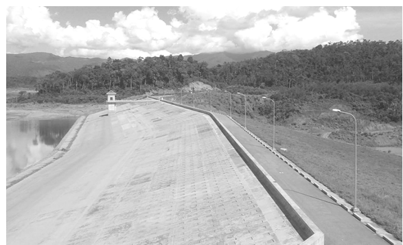
Hình 5. Hồ Thác Chuối đã hoàn thành
