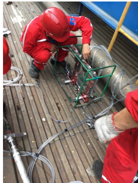
Hình 7. Thiết bị đo độ chênh áp nhằm xác định tốc độ dòng khí
