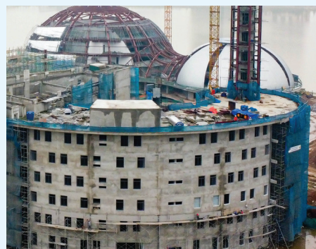
Một phần mái của công trình có dạng mặt Paraboloid Hyperbolic
