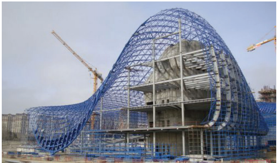
Trung tâm Văn hóa Heydar Aliyev trong quá trình thi công (Ảnh: building.co.uk)
