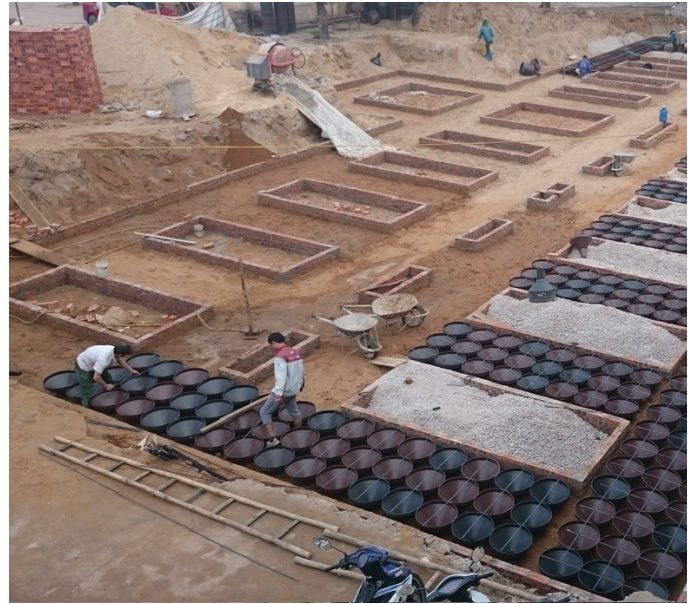
Thi công móng top base
