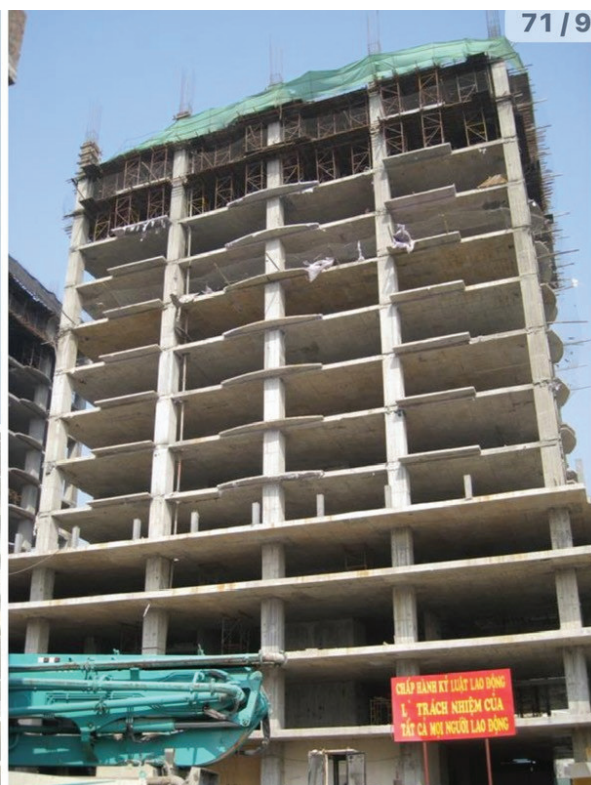
Khu nhà ở cán bộ chiến sĩ công an - Quận Hoàng Mai
