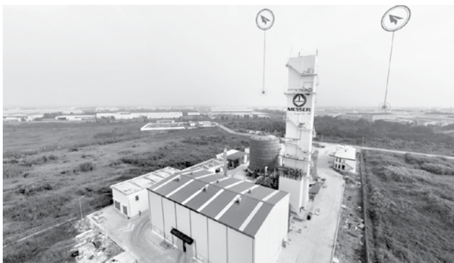
Hình 6. Dự án Messer Long An- Công ty MGD
