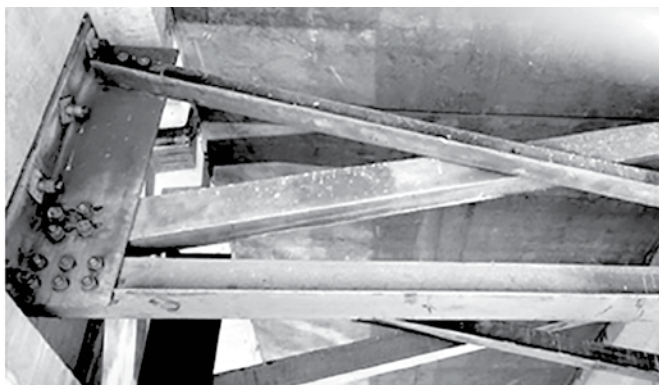
Hình 5. Hình ảnh chụp dầm phía trên trụ cầu trong giai đoạn bảo trì bằng drone
