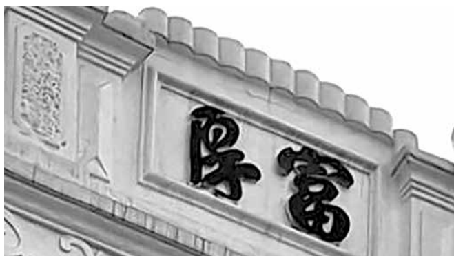
Các chi tiết đặc trưng trên mặt tiền nhà ở phố HVT, ND Ảnh bài báo thực hiện
