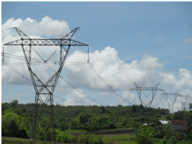
Trong giai đoạn 2011-2015, sẽ có hơn 2.773 km đường dây 500 kV được xây dựng
