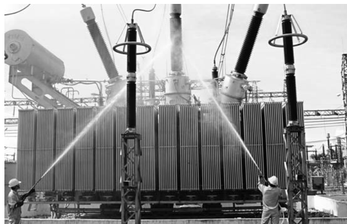
Công nhân PTC3 vệ sinh máy biến áp 220 kV bằng đề tài Vệ sinh sứ cách điện khi đang mang điện bằng nước áp lực cao
