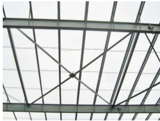
Hình 2. Giằng mái bằng thép góc đều cạnh (giằng chữ thập)
