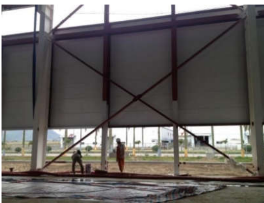
Hình 1. Giằng cột bằng thép góc đều cạnh (giằng chữ thập)
