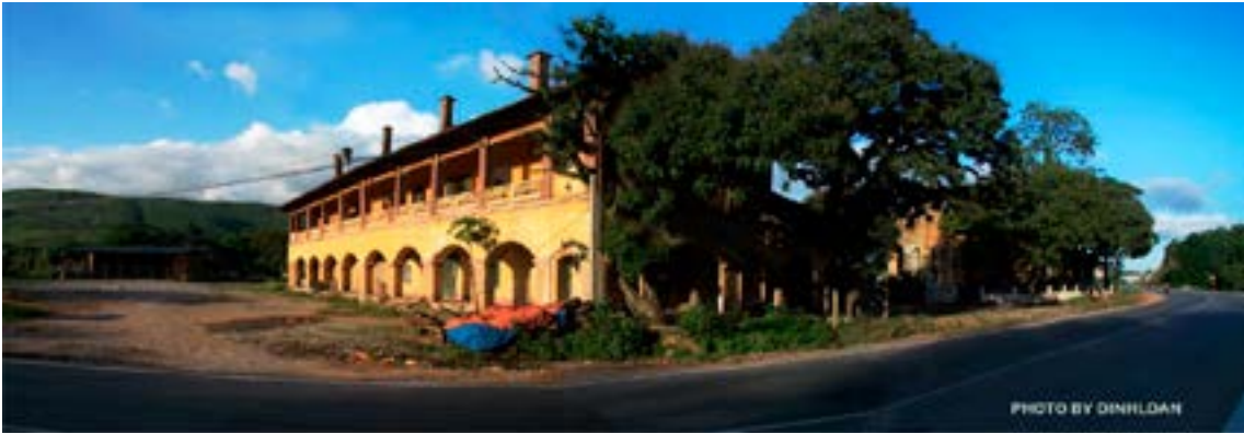
Hình 1.4. Một công trình thuộc địa Pháp tại Tiên Yên với đặc trưng phong cách kiến trúc địa phương Pháp
