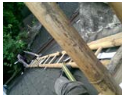
Hình 1.8. Tiếp cận mái một công trình thuộc địa tại Hà Nội
