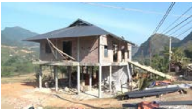
Hình 12. Nhà xây sử dụng gạch nung[6]
