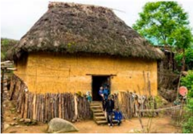
Hình 6. Nhà ở người Hà Nhì- Lai Châu và cách người dân trình tường đất[12]
