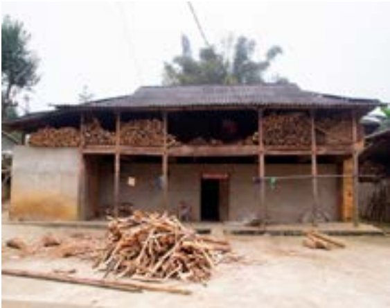
Hình 14. Người Mông sử dụng tường trát xi măng và nền xi măng[7]
