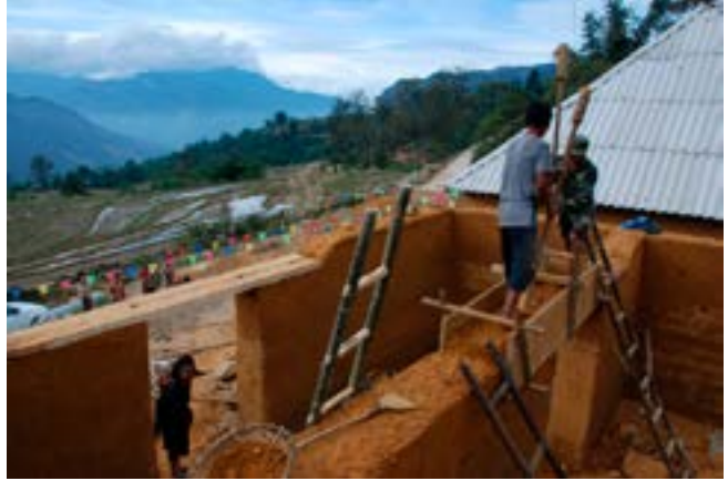
Hình 6. Nhà ở người Hà Nhì- Lai Châu và cách người dân trình tường đất[12]
