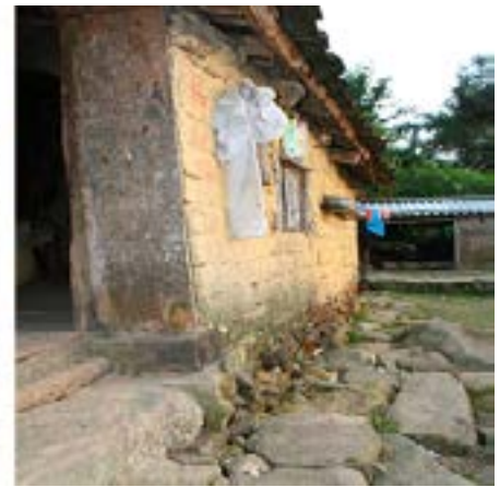
Hình 10. Nhà trình tường đất của người Hà Nhì Y Tý[12]
