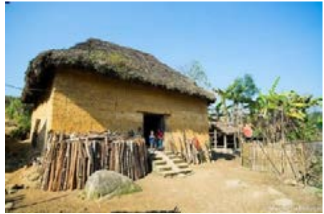
Hình 10. Nhà trình tường đất của người Hà Nhì Y Tý[12]
