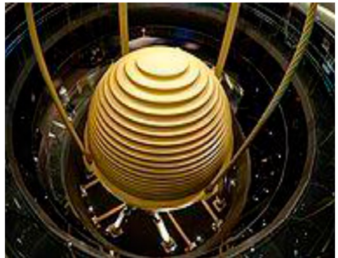
Hình 6. Vị trí thiết bị giảm chấn khối lượng điều chỉnh Tòa nhà Taipei 101, Đài Loan ( https://vi.wikipedia.org )
