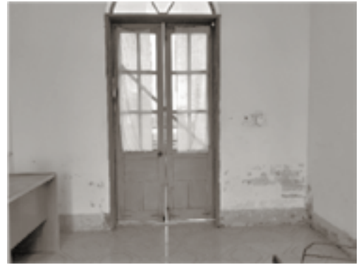
Hình 2. Nhà ban chỉ huy doanh trại tại Bạc Liêu có chân tường bị bong tróc do hiện tượng ngập úng vào mùa mưa
