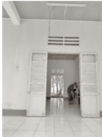
Hình 5. Giải pháp thông gió cửa trước sau và che nắng đầu hồi nhà ở chiến sĩ tại Kiên Giang
