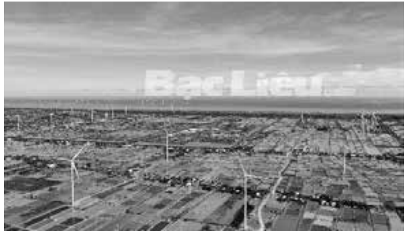
Hình 7. Hình ảnh tổng thể nhà máy điện gió Hòa Bình 5
