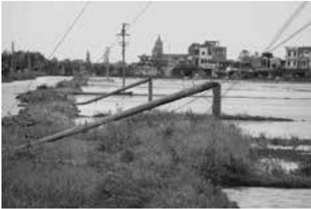
Hình 1. Cột điện bị gãy tại Nam Định
