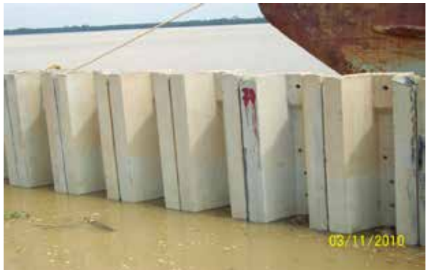
Hình 6. Cọc ván ứng lực trước dạng sóng
