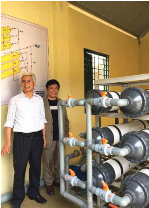
Hình 7. Hệ thống xử lý nước sinh hoạt từ suối Tà Vải (Hà Giang) a). Sơ đồ công nghệ. b). Thiết bị lọc màng UF
