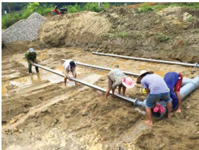
Hình 5. Lắp đặt ống lọc tại công trình thử nghiệm ở Lào Cai
