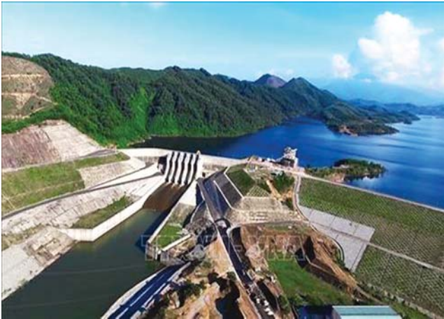
Hình 2. Cáp nước sinh hoạt từ nguồn hồ chứa thủy điện
