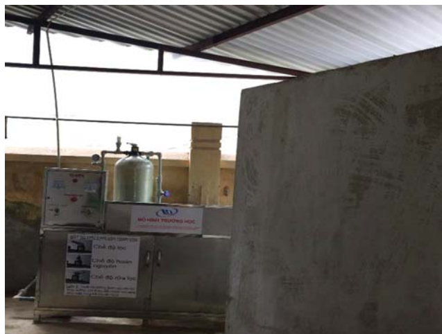
Hình 6. Mô hình bể chứa nước mưa và xử lý nước cho trường học ở Bắc Kạn
