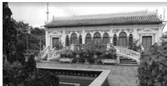
(** 2009) Nhà cổ Bình Thủy - 1870 144 Bùi Hữu Nghĩa, Q. Bình Thủy
