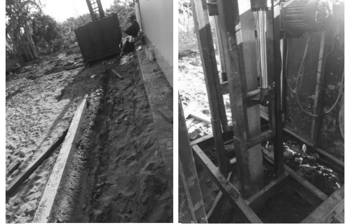
Hình 6. Làm bằng phẳng nền và ép cọc
