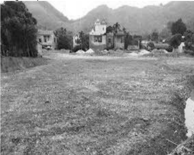
a) Ép cọc khu vực kênh rạch cạn
