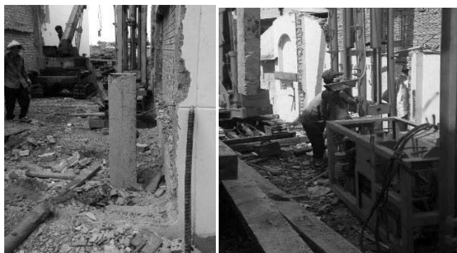
Hình 3. Thi công ép cọc thực tế (ép trên nền đất cũ)
