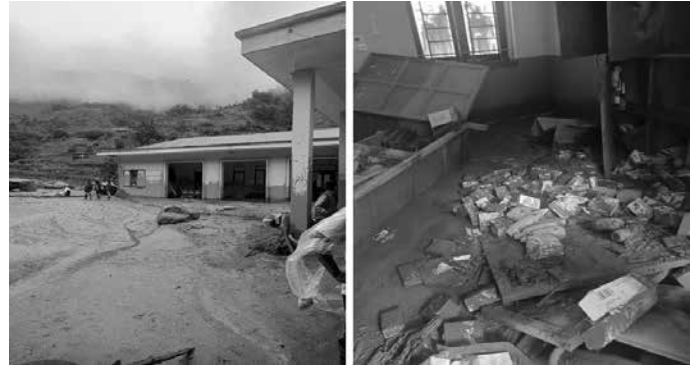
Hình 2. Hậu quả sạt lở đất ở trạm y tế
