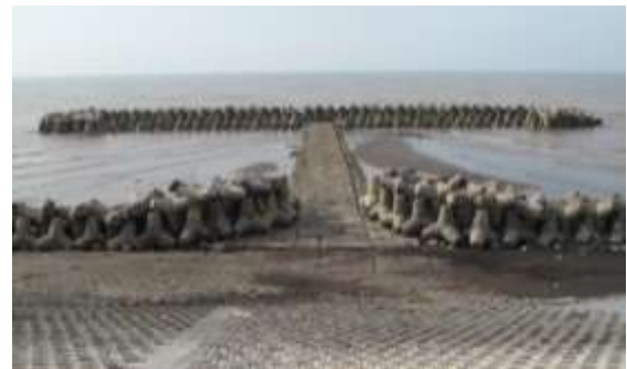
Hình 1: Hiện trạng hệ thống đê biển và một số giải pháp tiêu giảm sóng đã áp dụng tại Nam Định
