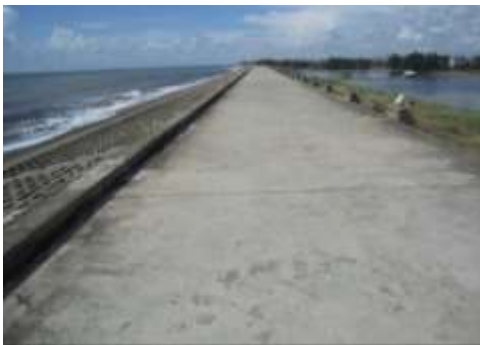
Hình 1: Hiện trạng hệ thống đê biển và một số giải pháp tiêu giảm sóng đã áp dụng tại Nam Định
