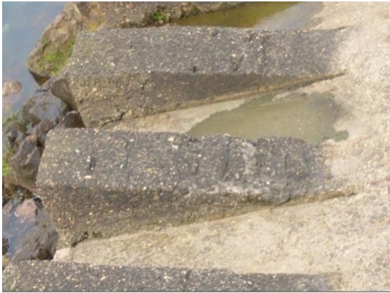
Ảnh 3: Mũi phun tràn Núi Cốc bị xâm thực, hư hỏng
