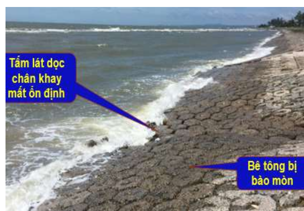
Hình 13: Kè bờ biển khu vực bãi tắm Đồi Dương 2024 [8]
