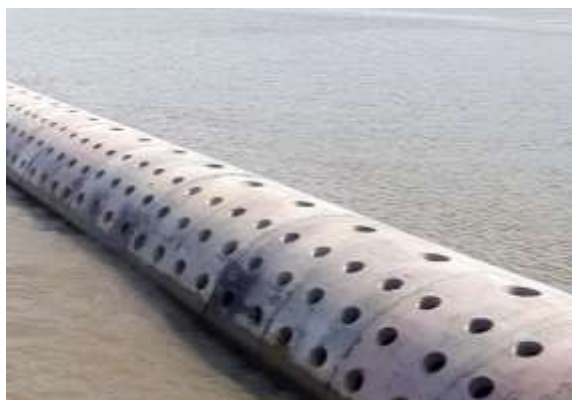
Hình 18: Cấu kiện nối ghép Max 400 có khả năng tháo lắp, di chuyển ứng dụng cho công trình giảm sóng xa bờ
