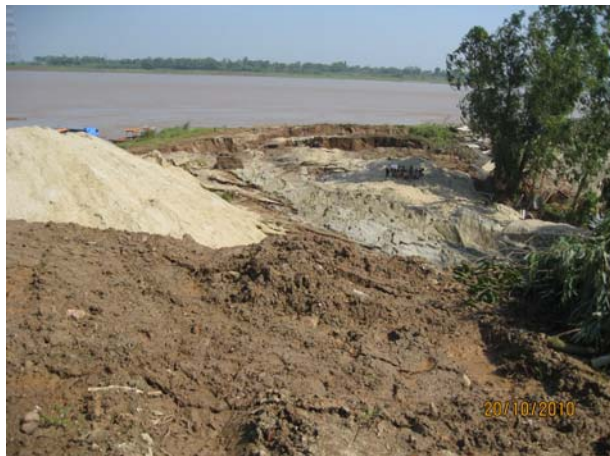
Hình 3. Sự cố lún, nứt đê Phú Thịnh-Hà Nội
