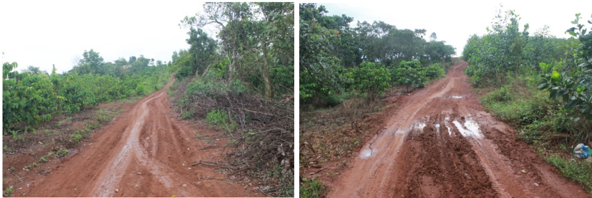
Hình 4. Hiện trạng đoạn đường thí nghiệm
