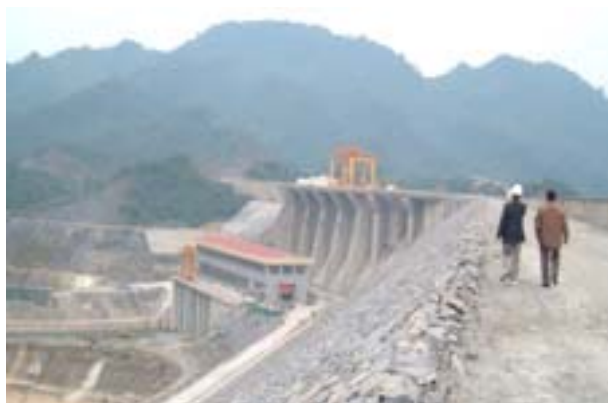
Hình 1. Đập Tuyên Quang (Đập đá đổ bê tông bản mặt)
