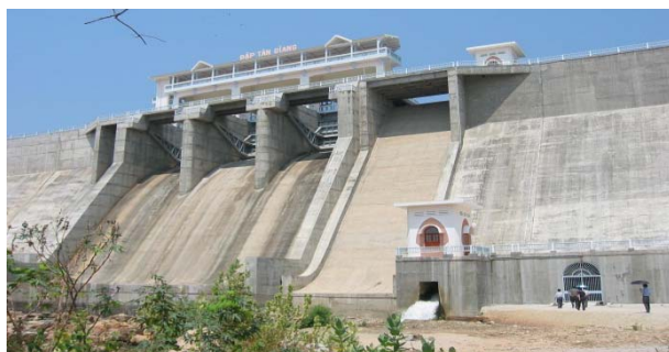
Hình 2. Đập Tân Giang (Đập bê tông truyền thống CVC)
