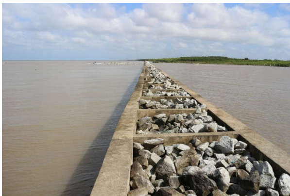
Hình 1.1: Đê giảm sóng bằng hai hàng cọc ly tâm kết hợp đá đồ ở Phú Tân Cà Mau (2017)
