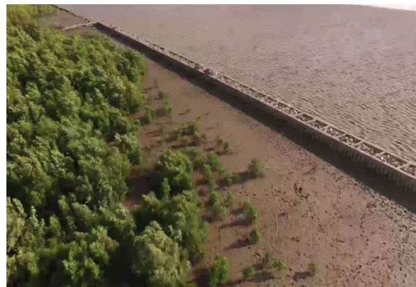
Hình 1.1: Đê giảm sóng bằng hai hàng cọc ly tâm kết hợp đá đồ ở Phú Tân Cà Mau (2017)
