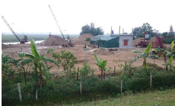
Hình 9: Bãi tập kết vật liệu phía sông
