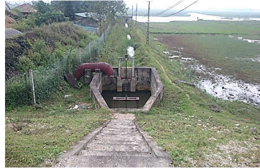
Hình 8: Bể xả và kênh dẫn phía sông
