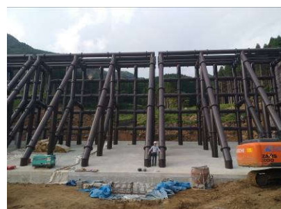
f) Đập hở kết cấu dàn thép tại Kyushu, Nhật Bản (tác giả chụp 7/2019)
