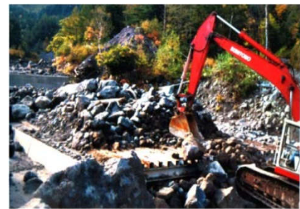
f) Trầm tích trên công trình phá dòng được bốc bỏ trước khi trận lũ mới xuất hiện.
