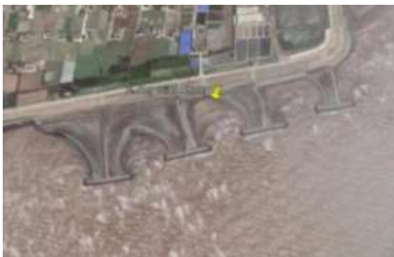
Hình 1.1: Công trình NCGS Ang Giao Phong
