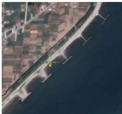
Hình 1.4: Công trình NCGS Hải Thịnh II
