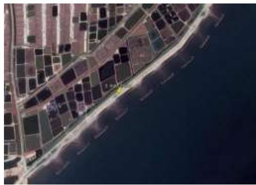
Hình 1.2: Công trình NCGS Kiên Chính
