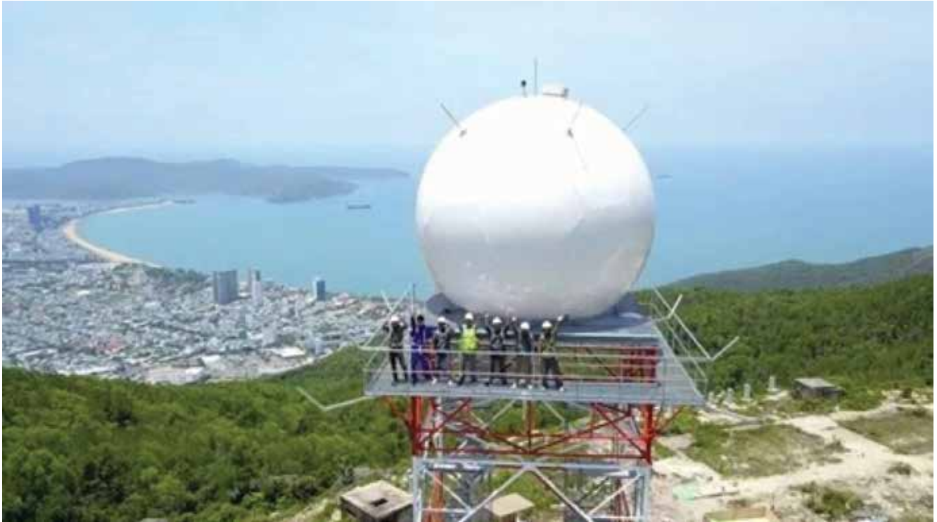
▲ Trạm radar thời tiết Quy Nhơn (Bình Định) thuộc đài KTTV khu vực Nam Trung bộ hoạt động chính thức từ ngày 1/1/2020
