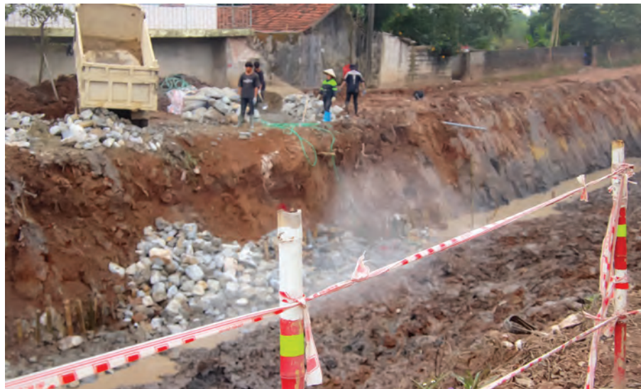
Dự án Cải tạo, kè mái sông S6-1, huyện Kim Động
