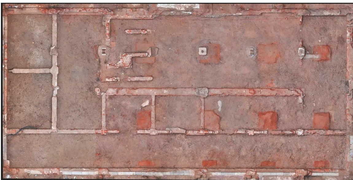
Hình 6. Hệ thống móng của tòa nhà CT04 sau khi hạ giải
