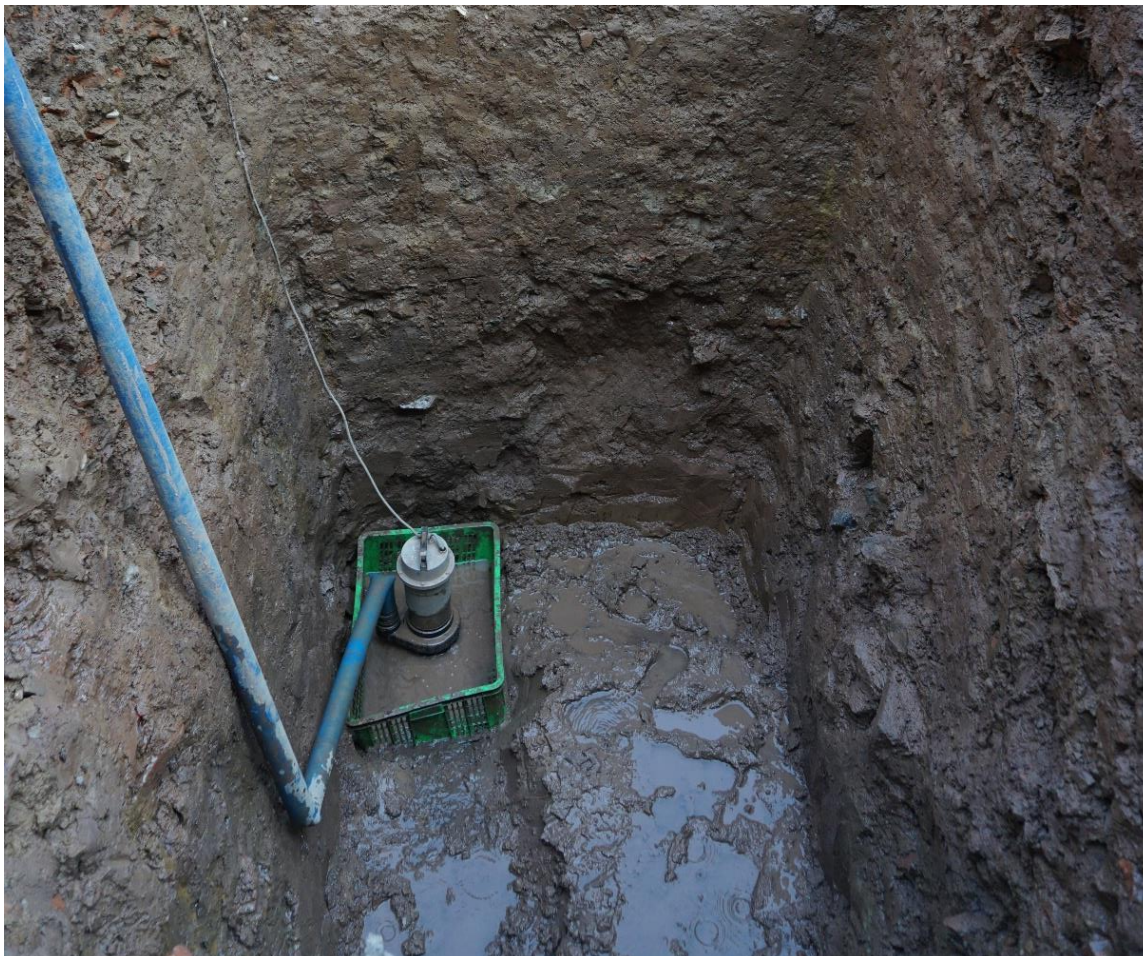
Hình 5. Địa tầng mặt cắt hố kiểm tra phía Tây Bắc xuất hiện với lớp văn hóa thời Lý và Đại La (Nguồn: Nhóm tác giả)
