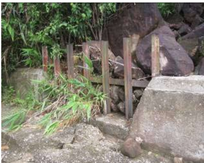
Hình 3: tường kè kết cấu ray chắn đá lăn tại Km 464+400, đường Hồ Chí Minh đoạn Thạnh Mỹ - Prao, xây dựng năm 2006
