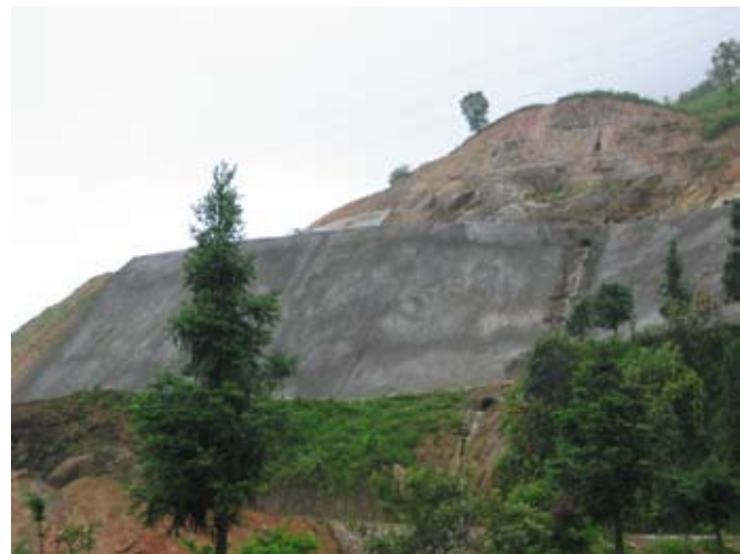
Hình 1: vỏ xi măng lưới thép gia cố mái dốc đoạn cua 3 tầng, quốc lộ 4D
