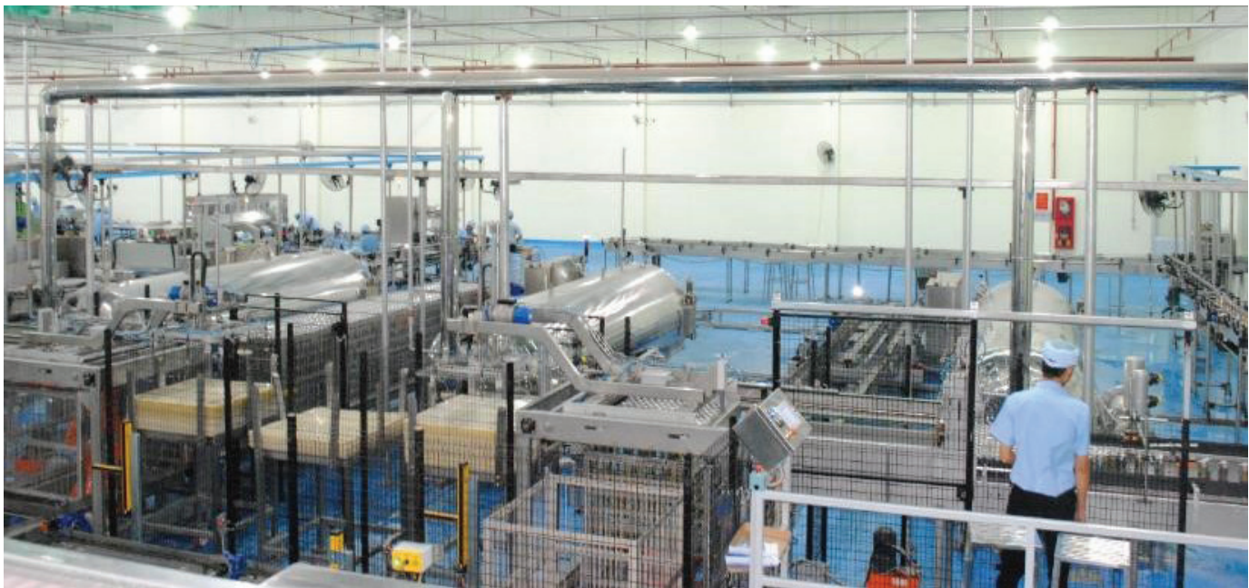
Hệ thống tiết trùng của Công ty Yến sào Khánh Hòa.
