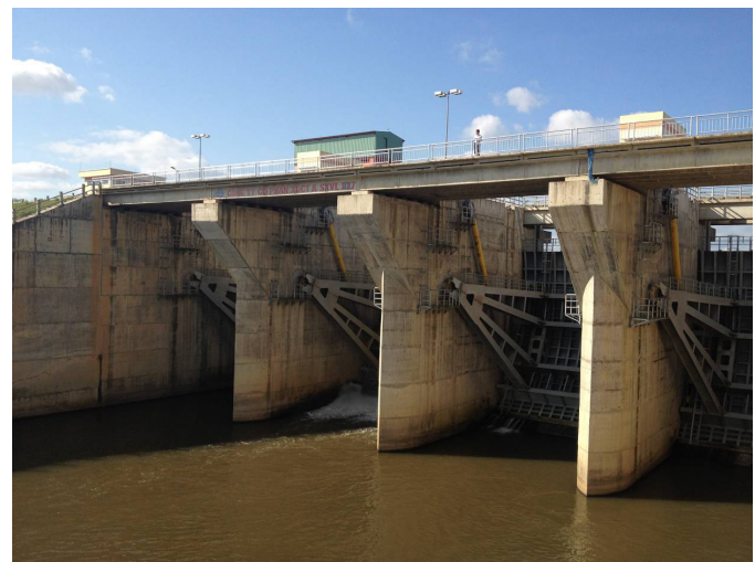
Đập Thủy điện An Khê - Kanak (Gia Lai)
