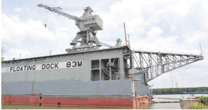
Ụ nổi 83M - dự án sai phạm nghiêm trọng của Vinalines
