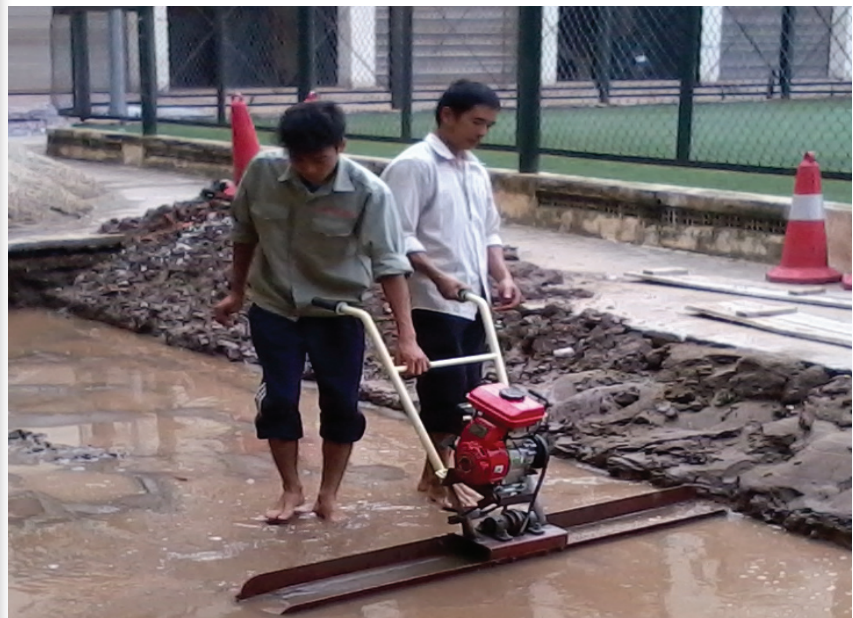
Hình 1: thử nghiệm máy đầm thước VSr.B1 trên nền cát
