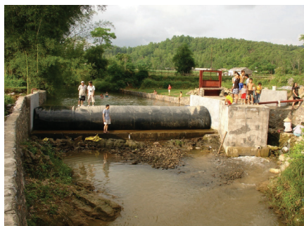
Đập cao su và trạm bơm thủy luân được lắp đặt hoàn chỉnh tại Cao Bằng
