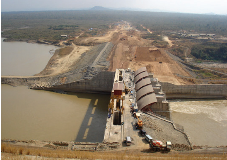
Đập đa năng có thể mở để thoát lũ và đóng để ngăn mặn, giữ ngọt
