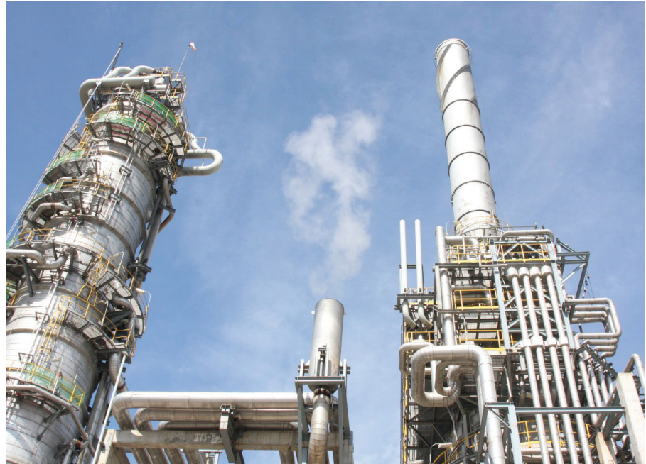
Nhà máy lọc hóa dầu Dung Quất.
