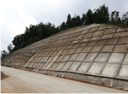
Hình 3. Gia cố bờ dốc bằng đinh đất, khung bê tông cốt thép, bê tông phun, thoát nước đường cao tốc Bắc Giang - Lạng Sơn (Công ty Cổ phần Xây dựng và Phát triển Hạ tầng ATV Việt Nam thực hiện, năm 2019).
