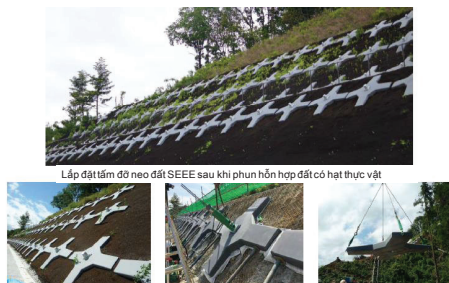
Hình 6. Gia cố bờ dốc bằng neo đất của SE có tấm đỡ tạo cảnh quan.
