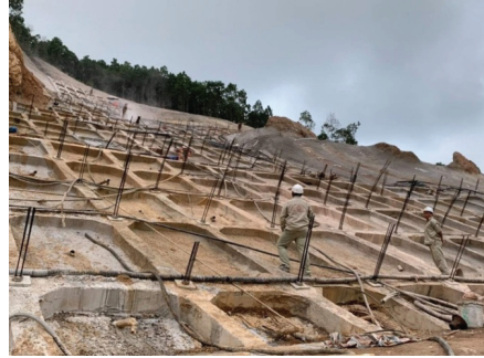
Hình 4. Gia cố bờ dốc bằng neo cáp, khung bê tông cốt thép, bê tông phun, thoát nước đường cao tốc Hạ Long - Vân Đồn (Công ty Cổ phần Xây dựng và Phát triển Hạ tầng ATV Việt Nam thực hiện, năm 2019).
