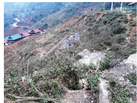
Hình 2. Trượt đất tại khu tái định cư Nậm Khao, Mường Tè, Lai Châu (2018).
