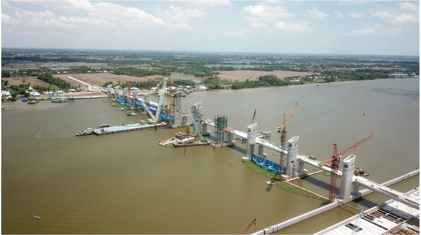
Hình 3. Quá trình thi công, xây dựng công trình cống Cái Lớn.
