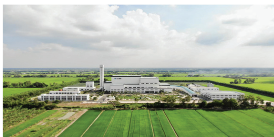
Nhà máy đốt rác phát điện, Cần Thơ
