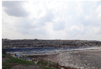
Bãi chôn lấp hợp vệ sinh, An Giang
