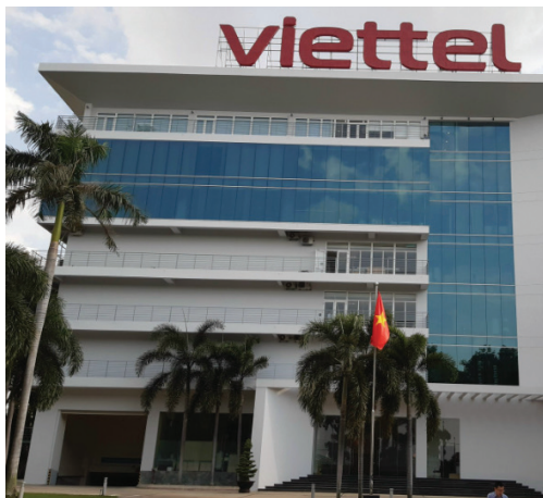
Hình 5. Hình ảnh công trình Viettel được gia cường bằng công nghệ vật liệu polymer cốt sợi carbon.
