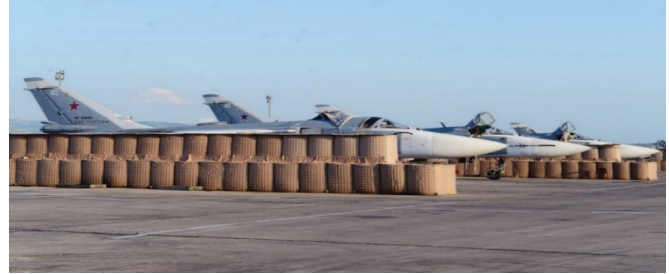
Hình 3. Ụ lắp ghép dã chiến bảo vệ máy bay trên căn cứ không quân của Nga.
