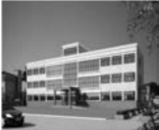
Hình 2c. Công trình ZEB của Trung Quốc. Nguồn: Tài liệu [5]
