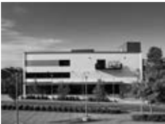
Hình 2a. Công trình ZEB của Mỹ. Nguồn: Tài liệu [5]
