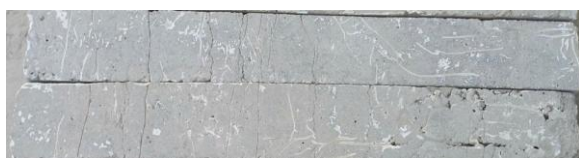
a) Vệ sinh làm sạch bề mặt các dầm
