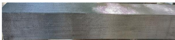
Hình 15. Dán tấm FRP lên bề mặt các dầm
