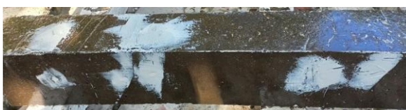
Hình 13. Lăn phủ lớp keo epoxy TCK 1401 lên bề mặt các dầm
