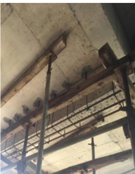
a) phương pháp đổ bù thêm bê tông
