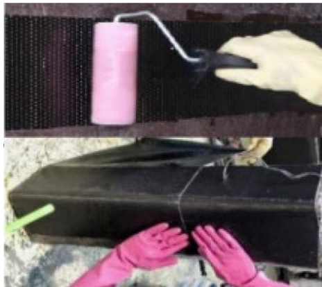
b) phương pháp dán tấm bề mặt bê tông
