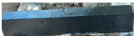
Hình 17. Các dầm được gia cường hoàn thiện
