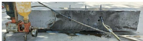
b) Bơm keo epoxy E500 xử lý vết nứt cho dầm Hình 11. Vệ sinh bề mặt và xử lý vết nứt dầm
