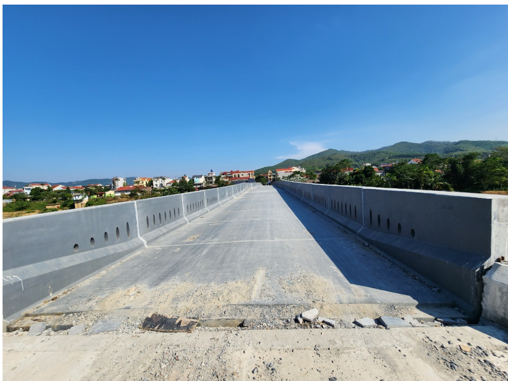
Hình 1. Cầu Vàng là cầu sử dụng dầm UHPC phân đốt căng sau đầu tiên tại Việt Nam.
